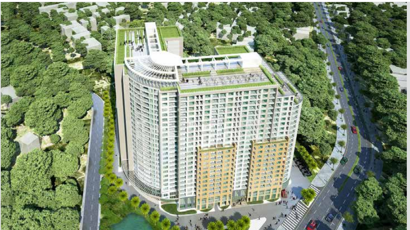
T&T Riverview - Hà Nội - Cung cấp và lắp đặt cửa kính căn hộ, cửa thép chống cháy Quy mô: 8.850m 2
