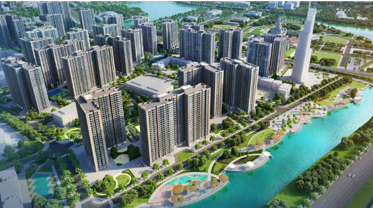
Vinhomes Ocean Park - Hà Nội - Cung cấp và lắp đặt cửa thép chống cháy - Quy mô: 2.800.000 m 2
